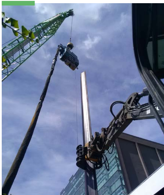
Confortement de digue (à gauche) et vibrofonçage de palplanches au droit d'un bâtiment (à droite) - Source : Nevers Agglomération
