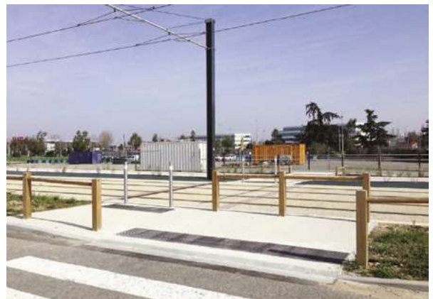
Traversée en section courante d'un site propre
