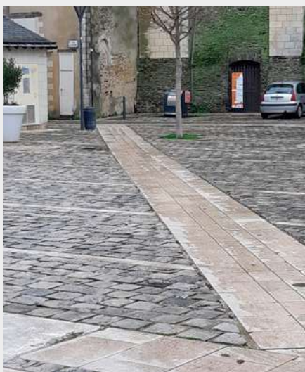
Exemple d'un cheminement avec un revêtement praticable par tous, et contrasté avec son environnement, intégré sur une place historique de la ville d'Angers (49).
