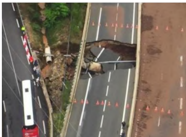
Figure 33 : Effondrement d'un remblai autoroutier sur l'A75 suite à l'érosion des matériaux contigus à un ouvrage hydraulique lors d'un épisode pluvieux particulièrement intense. (Sources : Figure de gauche - Détachement Aérien de Gendarmerie de Montpellier - Figure de droite, DIR MED)
