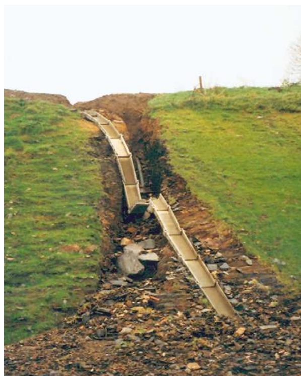
Figure 15 : Ravinements de talus de remblai dus à des débordements de descente d'eau (Source : Cerema Sud-Ouest)
