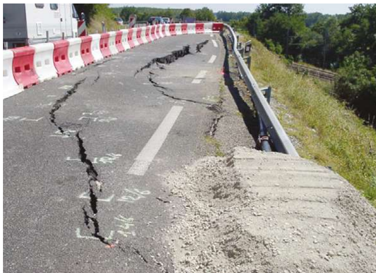
Figure 25 : Fissures circulaires avec rejet témoignant d'une rupture du talus de remblai (Source : Cerema Sud-Ouest)
