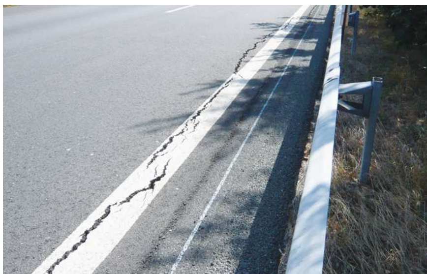
Figure 13 : Fissuration par retrait en lien avec le réseau racinaire des arbres (Source : Cerema Sud-Ouest)
