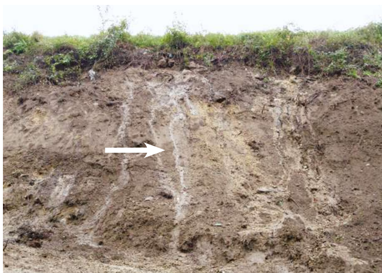
Figure 7 : Point de sortie d'eau piégée dans un remblai et se manifestant au moment de travaux de reprise de talus (Source : Cerema Ouest)
