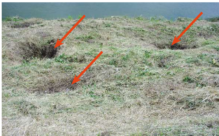
Figure 4 : Zone d'effondrement de la chaussée par suite de remontée d'une cavité karstique dans le remblai (Source : Cerema Normandie-Centre, Jargeau, 2001) - photo prise après rebouchage de la cavité (à gauche) aperçu du phénomène de soutirage par les cavités karstiques, en pied de remblai (à droite)
