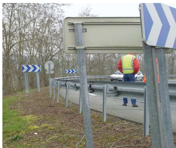
Figure 23 : Fissuration sur chaussée et basculement des panneaux de circulation en accotement provoqués par des phénomènes de reptation de talus (Source : Cerema Sud-Ouest)
