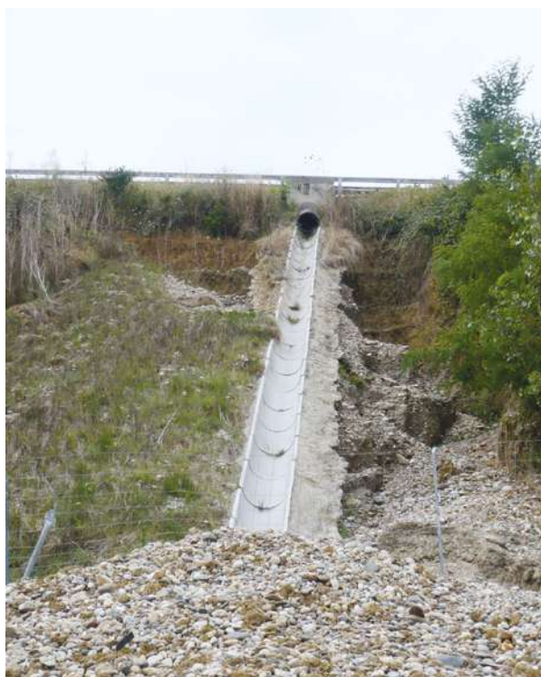
Figure 15 : Ravinements de talus de remblai dus à des débordements de descente d'eau (Source : Cerema Sud-Ouest)
