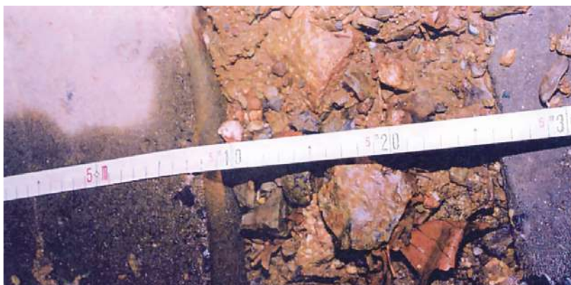
Figure 32 : Déboîtement d'éléments de buse préfabriquée, remontée de matériaux (Source : Cerema Sud-Ouest)
