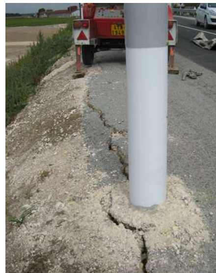
Figure 26 : La fissure longitudinale qui se manifeste au niveau des glissières ou en bord de remblai est due à des phénomènes de tassements différentiels caractéristiques d'un sous-compactage de bord de remblai (désordre P2). Ces phénomènes peuvent se manifester rapidement après la réalisation de l'ouvrage, lorsque le talus excédentaire n'a pas été réalisé ou éliminé, ou le plus souvent lors d'un élargissement de remblai. (Source : Université Gustave Eiffel)
