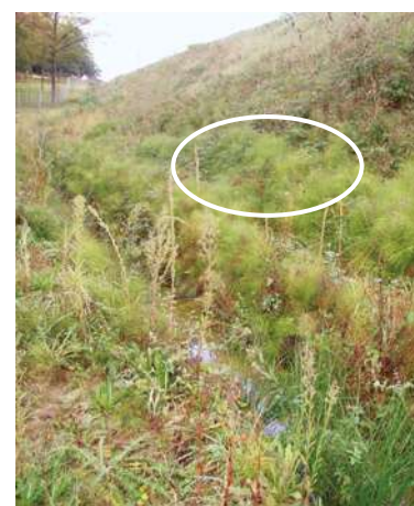
Figure 31 : Végétation typique de zones humides (prêles, rond blanc dans la figure) en pied de remblai (Source : Cerema Sud-Ouest)
