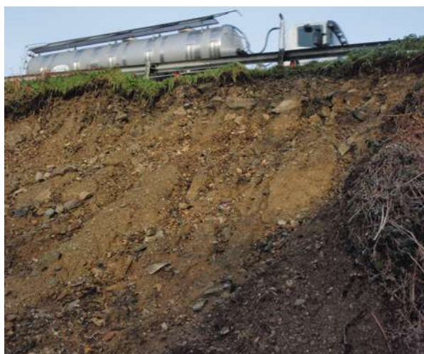
Figure 22 : Glissements superficiels (Source : Cerema Ouest)
