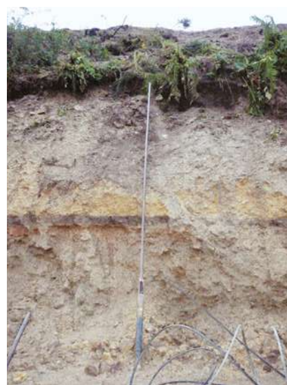
Figure 8 : Remblai sandwich présentant un contraste de perméabilité entre la couche noire imperméable et la couche ocre perméable (Source : Cerema Ouest)
