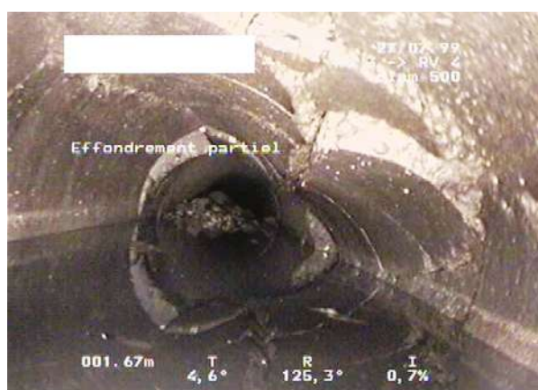
Figure 16 : Exemple d'auscultation de réseaux d'eau enterrés qui sont autant de point d'infiltration d'eau dans le remblai (à gauche déboîtement de tuyau, à droite, effondrement et obstruction d'un tuyau) (Source : Cerema Est)
