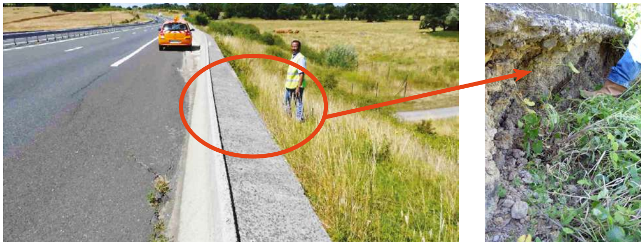
Figure 6 : Exemple d'érosion régressive du bord de talus, sous la glissière en béton armé (Source : Cerema Normandie-Centre)
