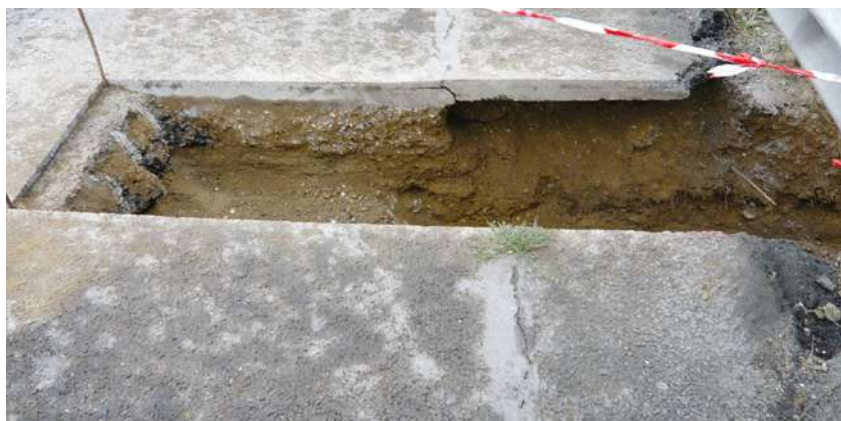
Figure 36 : Tranchée en bande d'arrêt d'urgence (Source : Cerema Sud-Ouest). La fissure coïncide avec la transition entre la structure traitée et le matériau érodé
