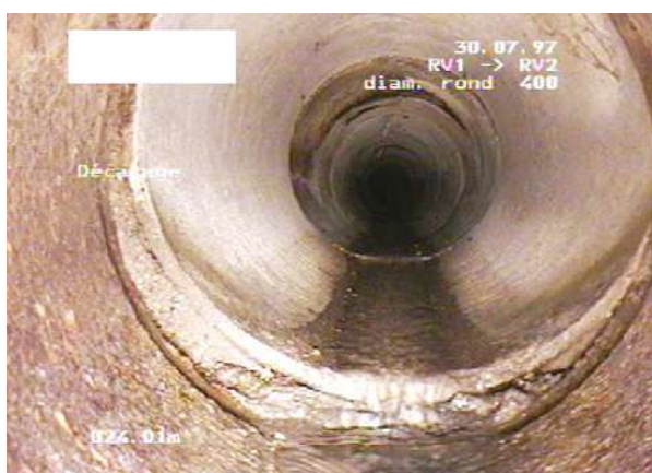
Figure 16 : Exemple d'auscultation de réseaux d'eau enterrés qui sont autant de point d'infiltration d'eau dans le remblai (à gauche déboîtement de tuyau, à droite, effondrement et obstruction d'un tuyau) (Source : Cerema Est)
