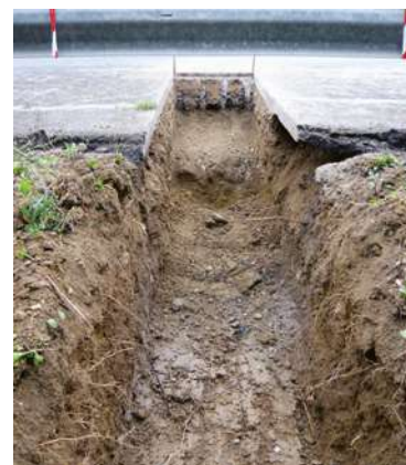
Figure 36 : Tranchée en bande d'arrêt d'urgence (Source : Cerema Sud-Ouest). La fissure coïncide avec la transition entre la structure traitée et le matériau érodé
