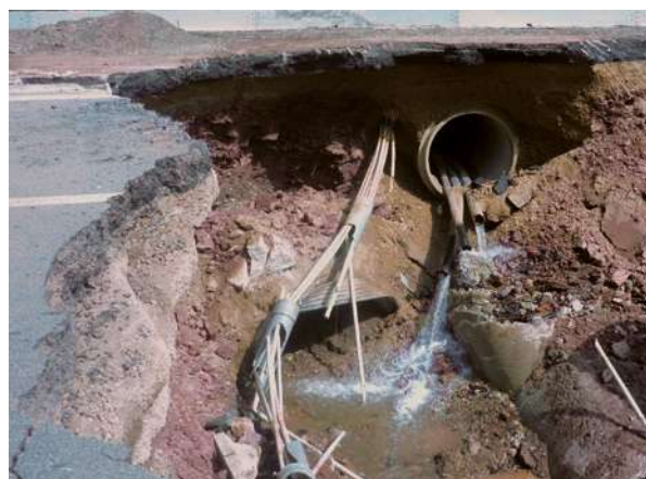
Figure 33 : Effondrement d'un remblai autoroutier sur l'A75 suite à l'érosion des matériaux contigus à un ouvrage hydraulique lors d'un épisode pluvieux particulièrement intense. (Sources : Figure de gauche - Détachement Aérien de Gendarmerie de Montpellier - Figure de droite, DIR MED)
