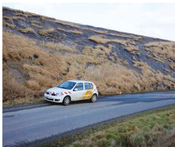
Figure 22 : Glissements superficiels (Source : Cerema Ouest)
