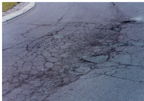
Défaut d'entretien du revêtement de la chaussée
