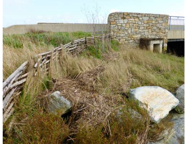
Illustration 5 : Vue sur les fascines mises en place. Crédit : Cerema – J.-F. Bretaud
