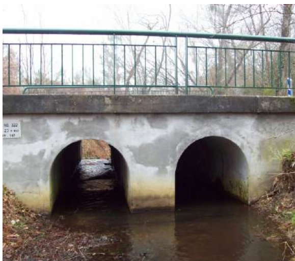
Illustration 3 : Vue de l'ouvrage amont avant reconstruction. Source : CD 33.
