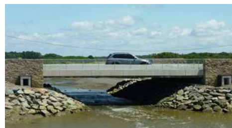
Illustration 1 : Vue d'ensemble du pont de la Voûte – Source : CD 44.
