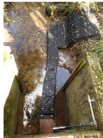
Illustration 15 : Vue sur l'amont de l'ouvrage – Source : Grege.
