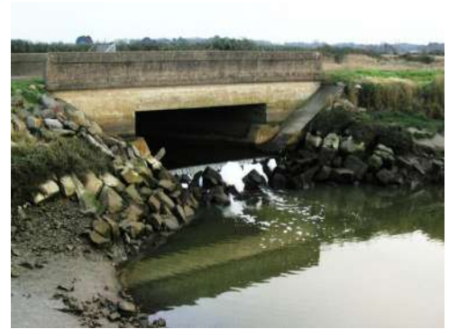
Illustration 3 : Ancien ouvrage et vue sur la chute. Source : CD 44.
