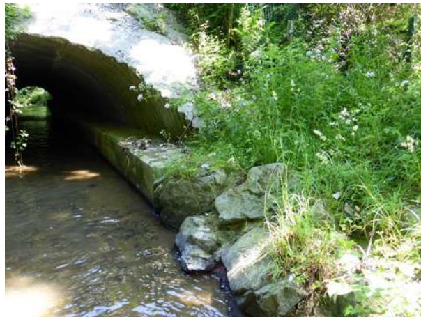
Illustration 13 : Vue sur la banquette en béton. Crédit : Cerema – J.-F. Breaud.
