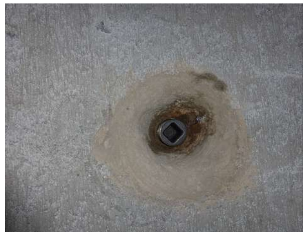
Illustration 16 : Vue sur le dispositif permettant l'injection d'un coulis béton
