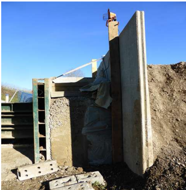
Illustration 13 : Vue sur l'organe de répartition de la poussée
