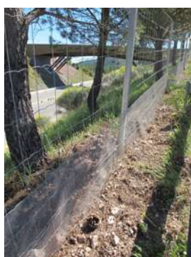
Illustration 3 : Écopont de Pignans et clôture faune Source : Cerema.
