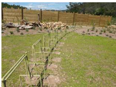
Illustration 6 : Système anti-intrusion (brevet INPI n° 125 97 54), barrière perméable à la faune mais barrant l'accès aux véhicules et deux-roues Source : Cerema.
