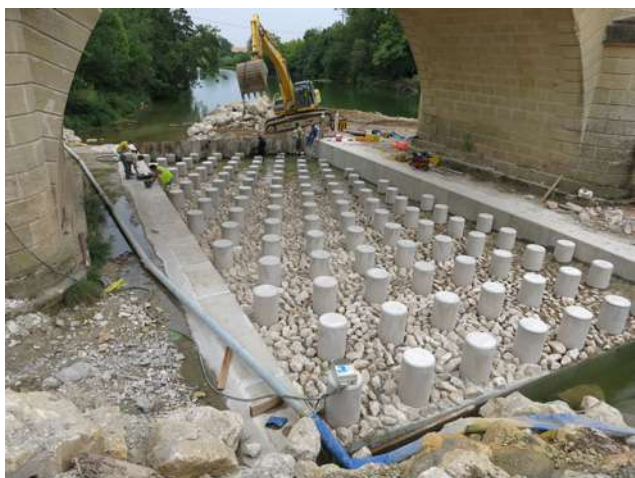
Illustration 10 : Vue sur la passe à poissons en travaux – Crédit : Cerema – A. Rosso-Darmet.
