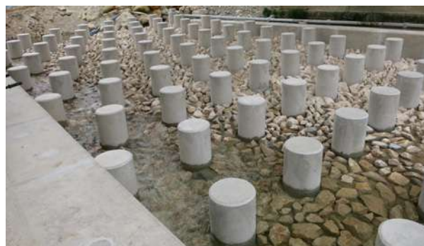
Illustration 8 : Détail sur les « menhirs » – Source : SNCF Réseau.
