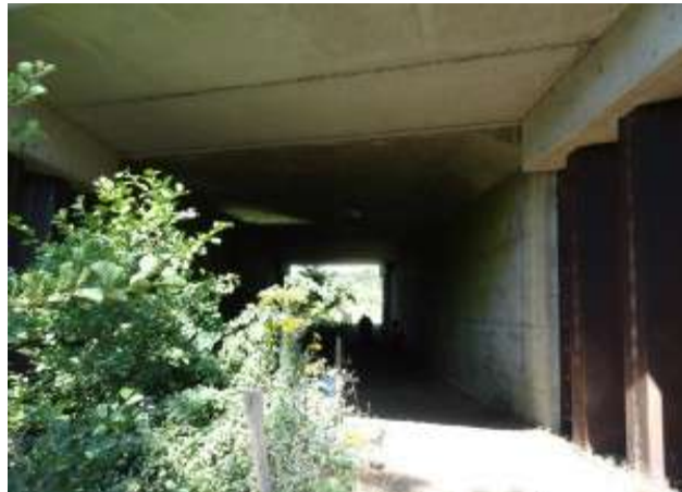
Illustration 8 : Passage mixte après élargissement Source : Sanef/SAPN.
