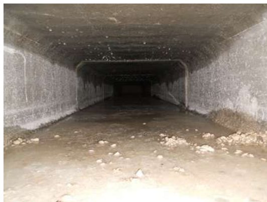
Illustration 9 : Substrat des traversées constitué de sable et de gravier – Crédit : C. Hervé.
