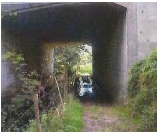
Illustration 9 : Passage mixte avant les travaux Source : Sanef/SAPN.
