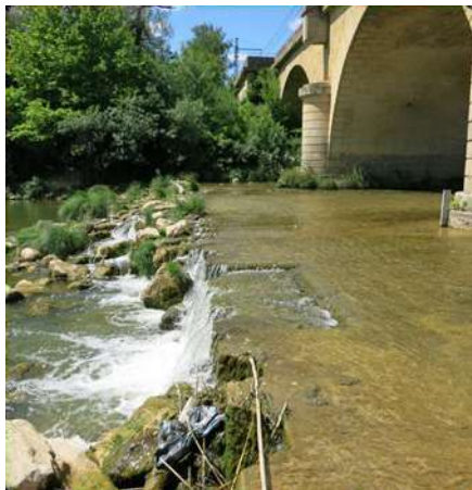
Illustration 5 : Vue sur le seuil – Source : SNCF Réseau.
