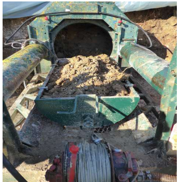
Illustration 14 : Vue sur le chariot d'évacuation des déblais
