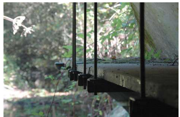
Illustration 12 : Vue sur l'intérieur de l'ouvrage. Crédit : Cerema – J.-F. Bretaud.
