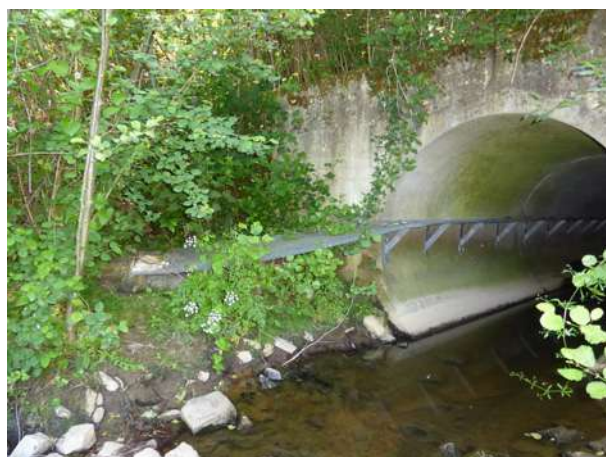
Illustration 9 : Vue sur l'amont de l'ouvrage Crédit : Cerema – J.-F. Bretaud.
