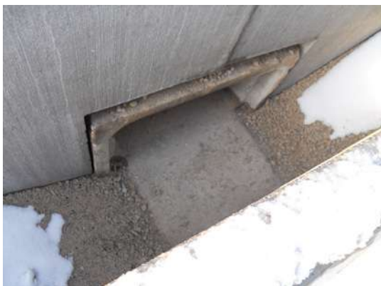
Illustration 8 : Traversée sous chaussée Crédit : C. Hervé.
