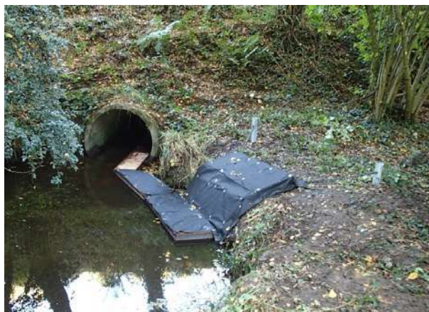
Illustration 14 : Vue aval de l'ouvrage – Source Grege.
