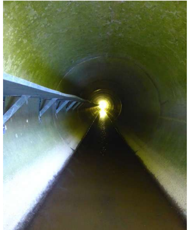
Illustration 10: Vue sur l'intérieur de l'ouvrage. Crédit : Cerema – J.-F. Bretaud.
