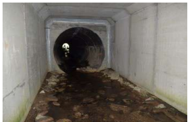
Illustration 5 : Intérieur du cadre amont et vue sur l'ouvrage d'origine Source : Sanef/SAPN.
