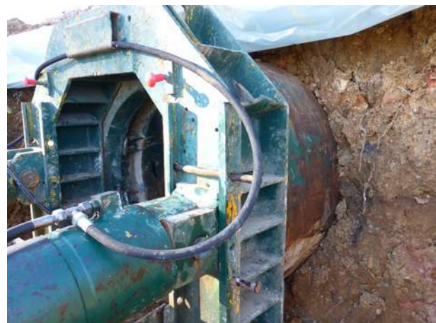
Illustration 12 : Vue sur l'élément de découpe du remblai
