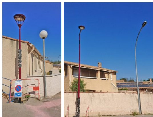
Illustration 7 - Luminaires LED posés lors de la rénovation de l'éclairage public du quartier des Bouroumettes (Pennes-Mirabeau), juxtaposés aux luminaires déposés (Source: Ville de Pennes-Mirabeau)
