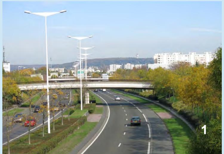
**Photo 1 : la section courante offre une large place aux espaces végétalisés, une chaussée réduite, une emprise pour créer une 3<sup>e</sup> voie**
