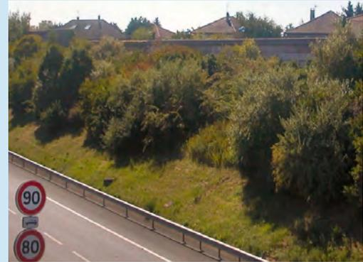
Réalisé entre 1992 et 2001 le boulevard urbain sud relie l'A7 et la rocade est et permet de desservir trois communes au sud de la métropole de Lyon. Il est situé dans un contexte périurbain où le bâti est peu dense. Les échanges sont espacés de 1 200 m. Réalisé en déblai il s'insère mieux dans le site. Des murs acoustiques protègent les constructions de type pavillonnaire.
