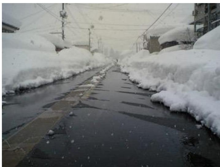
Figure 7.6 : Système de giclage à Tokamachi
