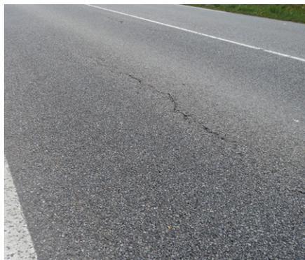
• Les fissures longitudinales, essentiellement aux droits des passages de roues, sont un signe de faiblesse structurelle.
