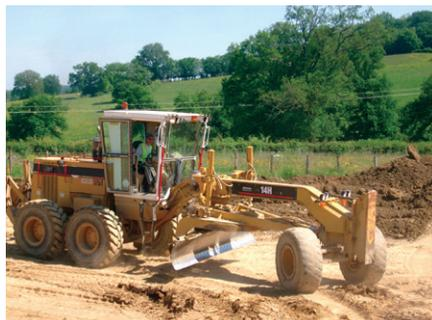
La phase de terrassement s'achève avec les travaux de réglage de la forme de la route conformément aux niveaux prévus pour assurer l'évacuation des eaux pluviales sur les bas-côtés. Pour les réaliser, des niveleuses (graders), engins de base des travaux routiers, et des boteurs légers à chenilles, dans le cas de talus à forte pente, entrent en action.
