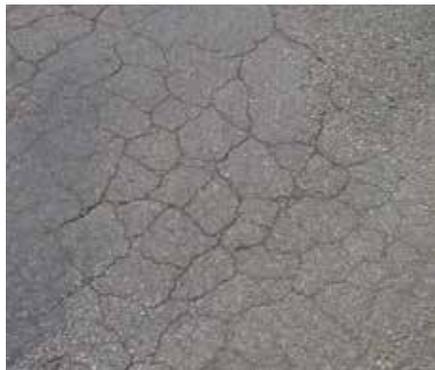
En l'absence d'un entretien adapté, ces fissures évoluent vers un faïençage, se soldant par une pénétration de l'eau et une fragilisation structurelle de la chaussée.
