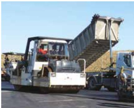
Les équipes réalisent enfin la couche de roulement, revêtement le plus important pour garantir les propriétés d'usage de la chaussée. Celle-ci sera compactée de la même manière que les couches d'assise.
