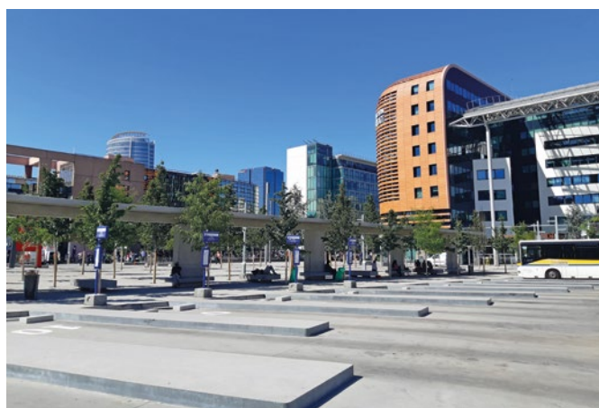
Gare routière située devant la gare SNCF de Lyon Part-Dieu
