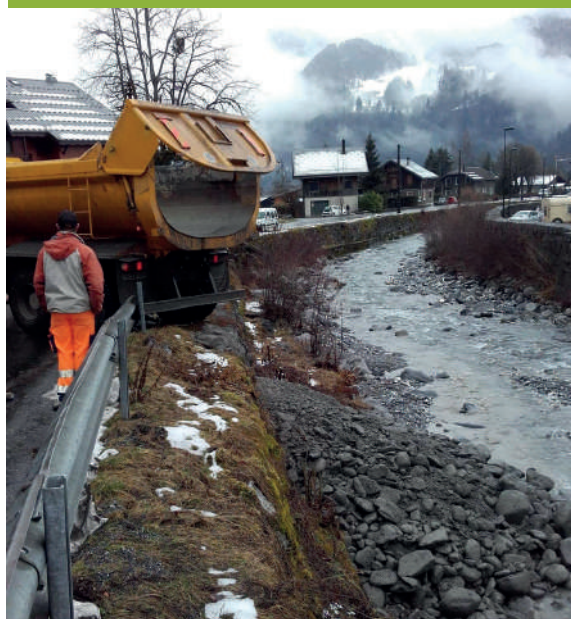
Sécurisation d'ouvrages (source : SM3A)
