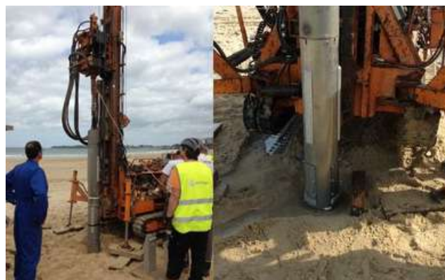
Illustration 30 : détail de l'utilisation du carottier
