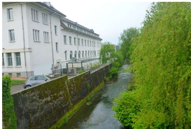
Mur en béton au droit du lycée Elie Cartan (La Tour du Pin)
