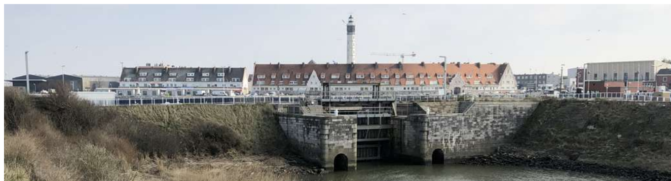
Illustration 20 : porte des 10 m et bassin des chasses du secteur de Calais Ouest
