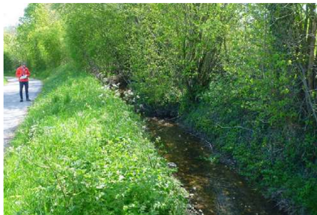
Vue du remblai en rive gauche de l'Hien (amont → aval)
