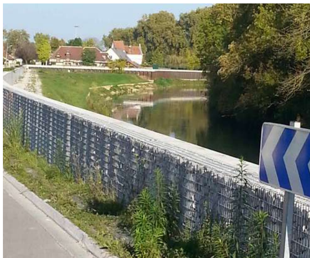
Illustration 77 : photos secteur Digue de Foicy. En haut : crue janvier 2018 - source : l'Est Eclair. En bas : octobre 2017 - source : Cerema.
