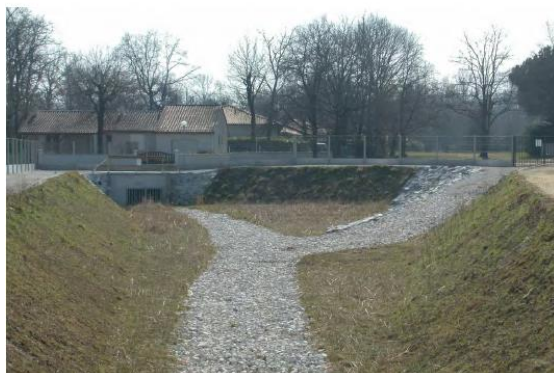
Figure 53 : Bassin Lagorce, Rue de Grattecap à Blanquefort (Communauté Urbaine de Bordeaux, 2014)
