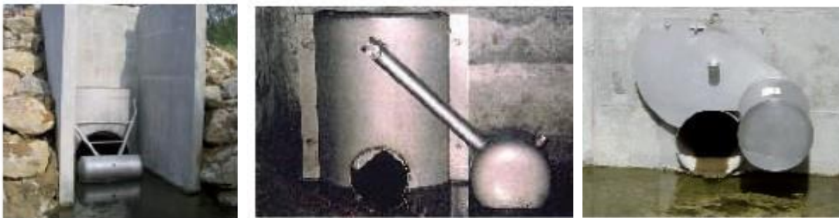
Figure 126 : Régulateurs à flotteur (Saint Dizier environnement)
