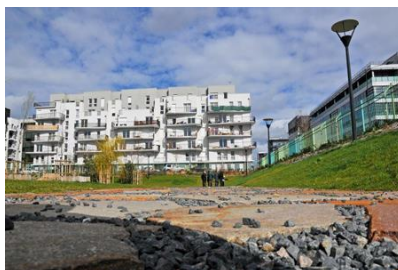
Figure 59 : Le square des Acrobates de la ZAC Landy Pleyel à Saint-Denis (Arene Ile-de-France, 2011)
