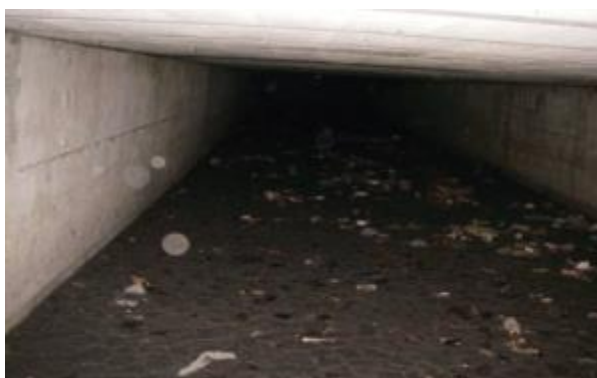
Figure 67 : Bassin enterré – Photo (Communauté Urbaine de Bordeaux, 2014)
