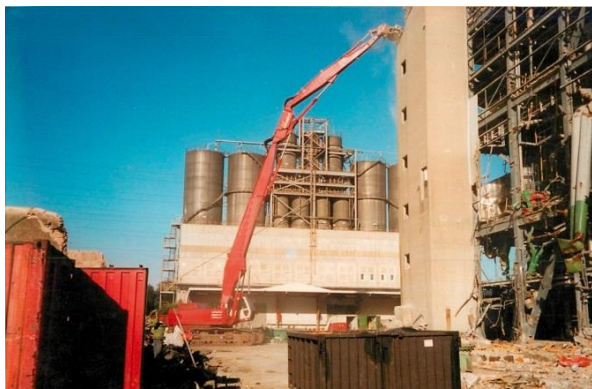
Chantier de démolition. Source: VERAS
