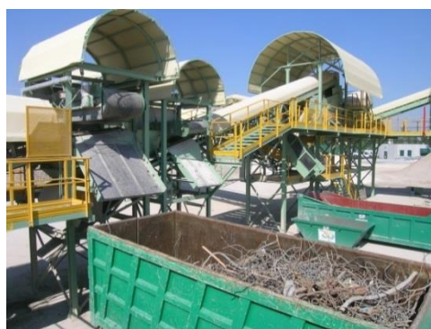
Usine de recyclage de déchets de C&D. Source: ANPAR
