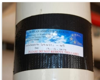
Conduites marquées à l'amiante. Source: UEPG
