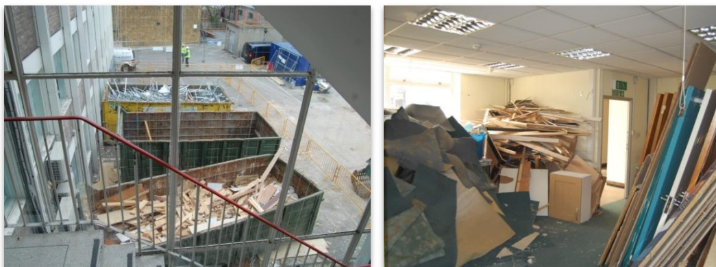
Tri à la source sur un chantier de démolition. Source: UEPG
