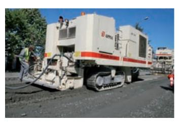
Le retraitement des chaussées en place au ciment ou aux liants hydrauliques routiers épargne les ressources en granulats et supprime les nuisances dues à leur transport.
