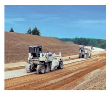
La technique du traitement des sols aux liants hydrauliques est de plus en plus utilisée pour les terrassements, mais aussi pour la réalisation des couches d'assises de chaussées.
