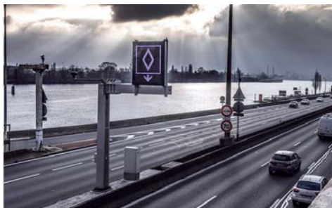
Ce panneau désigne principalement une voie dédiée au covoiturage, ici sur les boulevards urbains de Lyon Thierry Fournier-Métropole de Lyon
