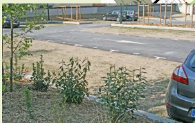
Places de stationnement perméables Source : Cerema
