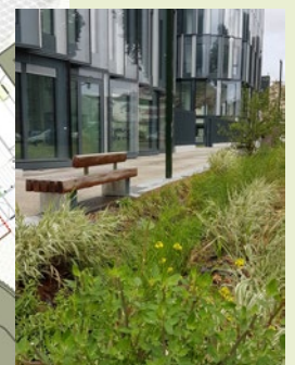
Noues Source : Arte Charpentier
