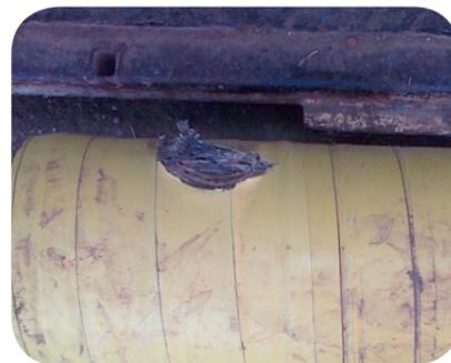
Les agents GRTgaz arrivés sur place, constatant un léger dégagement de gaz, ont isolé et dépressurisé le tronçon concerné. Cette mesure provisoire a été prise du fait de ne pouvoir procéder à une réparation immédiate : présence d'une galerie électrique haute tension, enjeu de sécurité ferroviaire (terrassment proche des voies).
