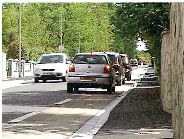
Crédit photo Cerema : accotement
