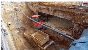
Le 11 octobre 2017, GRDF constate une situation à risques sur des travaux de construction d'un parking. La photo prise au moment de cette visite présente une situation à risques invraisemblable ! Une conduite Gaz en polyéthylène d'un diamètre de 125mm à une pression de 3,7 bar se trouve suspendue sur plusieurs mètres avec un vide de plus de 4 mètres. Juste sous la conduite de gaz, une entreprise réalise des travaux avec une pelle mécanique en effectuant des rotations avec le bras articulé.
