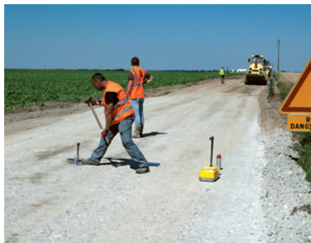
⬆ Contrôle de la compacité et de la teneur en eau de la chaussée à l'aide d'un gammadensimètre.
