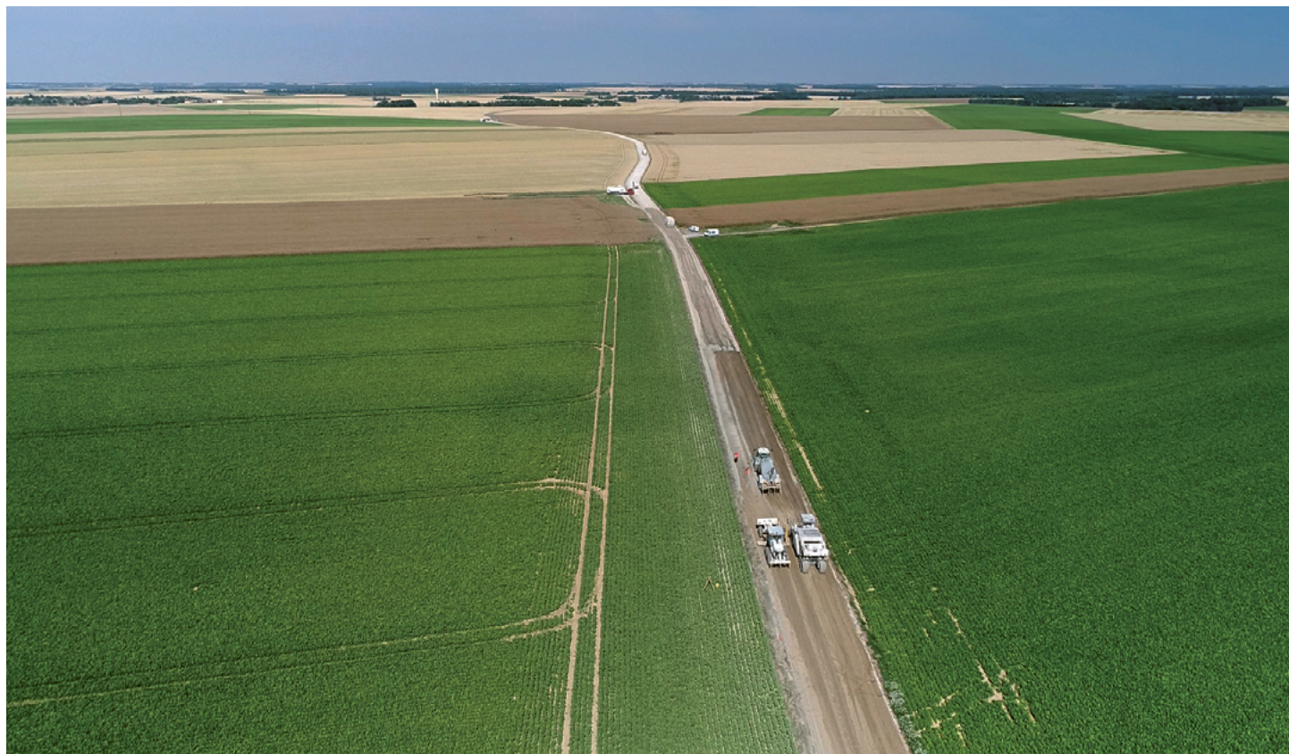
✓ Vue aérienne du chantier de retraitement à froid au liant hydraulique routier de la RD36a, réalisé par la société Routes et chantiers modernes (RCM), avec du Rolac Optimum de Saint-Pierre-la-Cour de LafargeHolcim.
