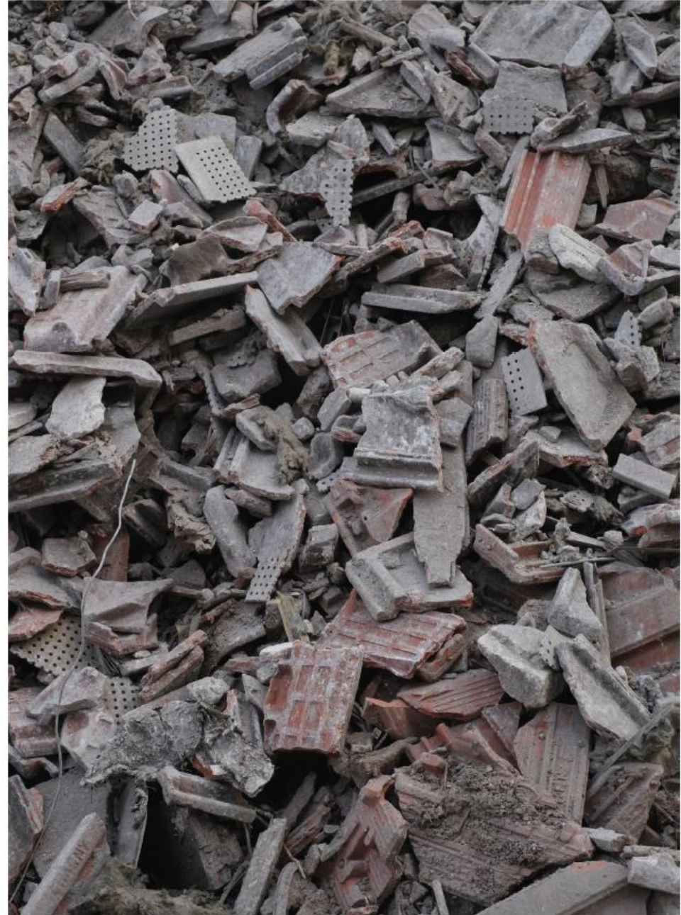
2023 Démolition de l'usine PSA à Saint Ouen
